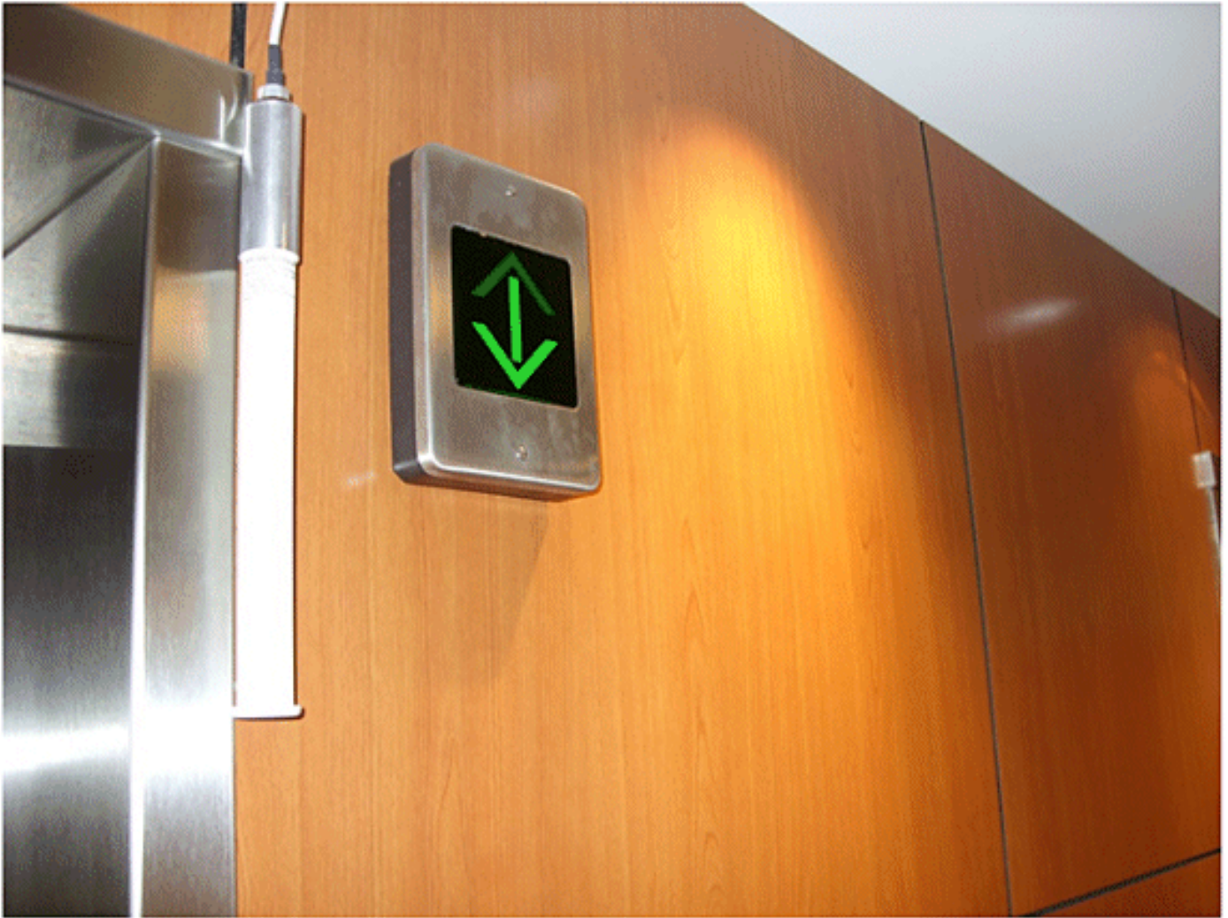
Figura 13: Ubicación deficiente de los puntos de acceso: puntos de acceso colocados cerca unos de otros
