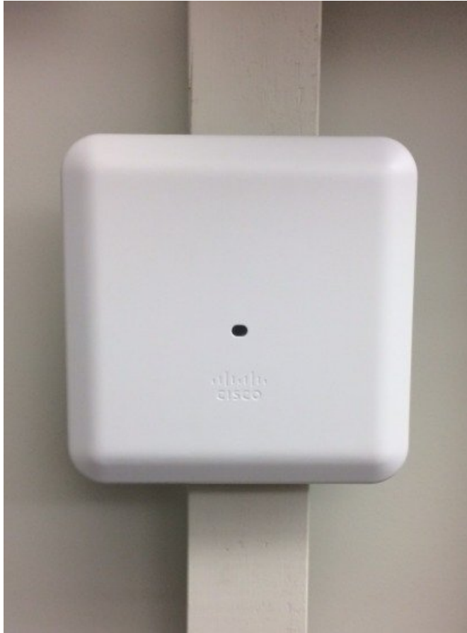
図 10: 内部アンテナ付きのユニットは壁面取り付けを避ける
