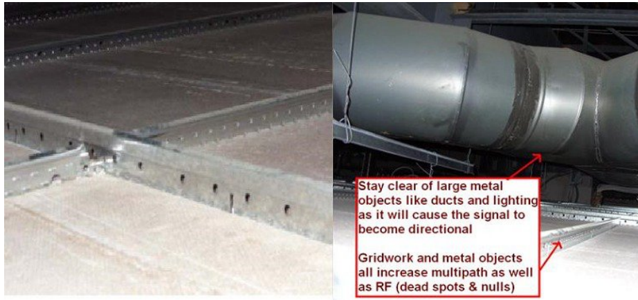
図 16: 天井タイルの上に AP を設置 : 障害物のない場所を選択し、天井の散乱物を避ける
