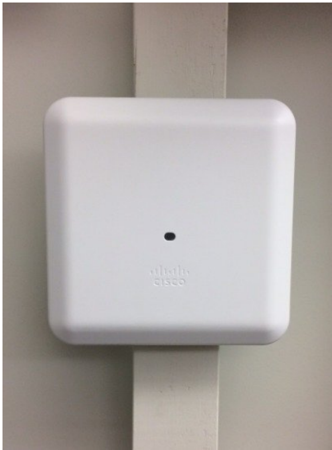
図 20: 内部アンテナ付きのユニットは壁面取り付けを避ける
