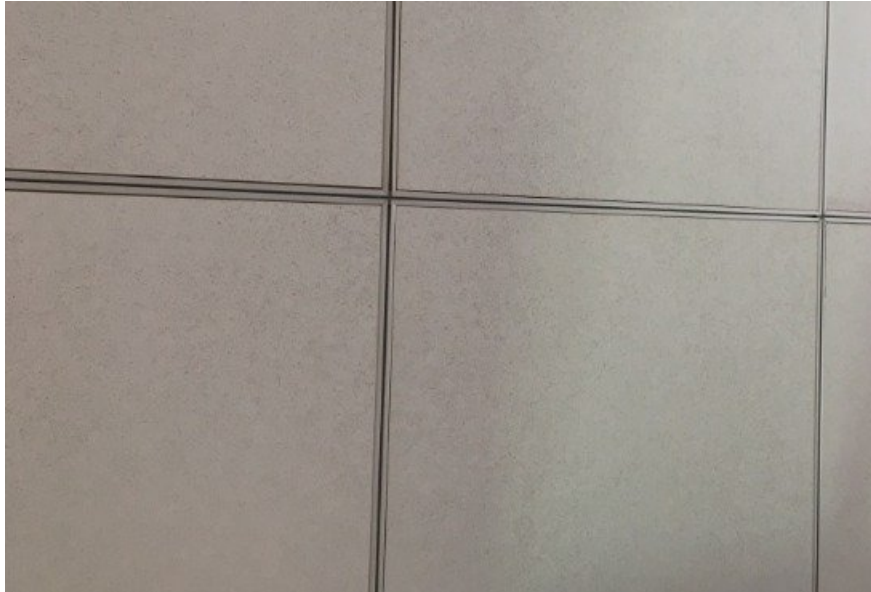
図 14: シン レール (埋め込み型レール) 天井で使用されるチャンネル レールの例
